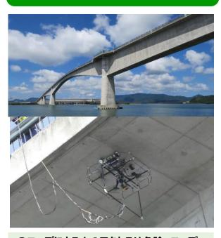
〇ロープによる人のアクセスは危険、ロープ、 点検足場設置はコスト高 〇大型橋梁点検車は交通渋滞を招く
