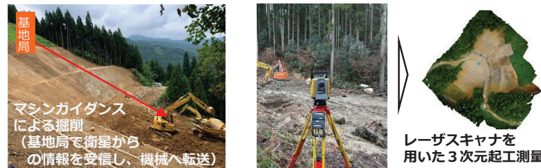
ICT等新技術の導入による施工の効率化や精度向上
