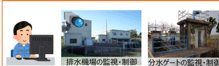
排水機場の監視・制御
