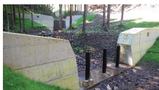
流木捕捉式治山ダムを設置
